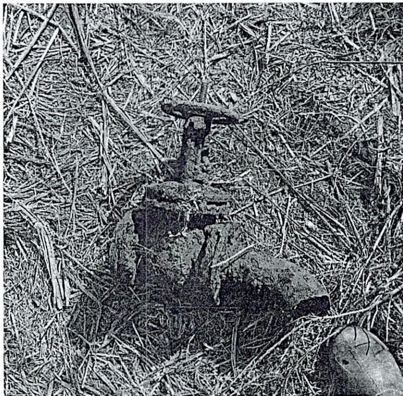
Рис. 2.4 Фотофиксация аварии по ул. Олимпийская, №3 (износ запорной арматуры)
