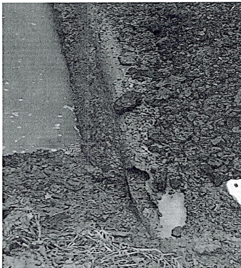
Рис. 2.2 Фотофиксация аварии по ул. Горького, №5 (негерметичность раструбного соединения)
